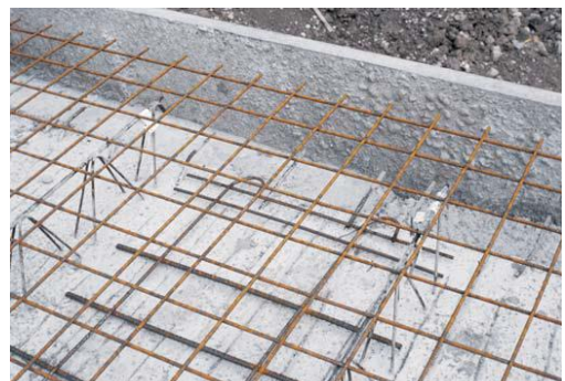
Obr. 10: Horná výstuž a styková výstuž
