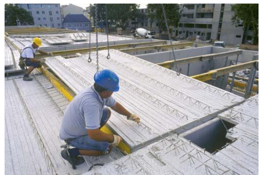
Obr. 9: Minimálna hĺbka uloženia: odporúčaná hĺbka je 5 cm, inak treba dosky na okrajoch podstojkovať
