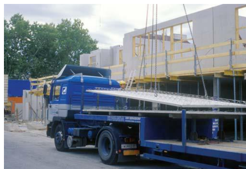
Obr. 14: Vykladanie stropných dosiek
