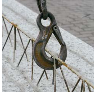
Obr. 5: Hák žeriava v uzlových bodoch priehradového nosníka
