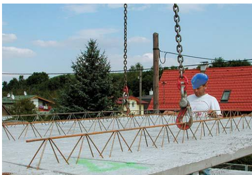
Obr. 12: Uloženie stropných dosiek
