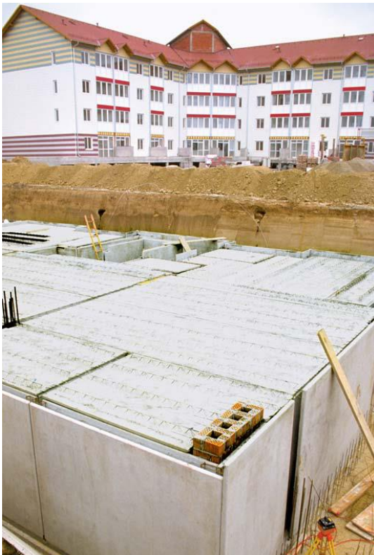
Obr. 17: Filigránový strop na veľkometrážnej pivnici
