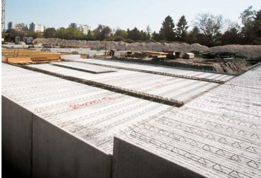
Obr. 16: Uložený filigránový strop
