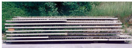
Obr. 7: Skladovanie stropných dosiek
