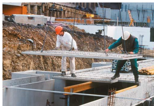
Obr. 15: Kladenie stropných dosiek
