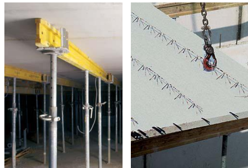
Obrázok 3 a 4: Montážne podstojkovanie
