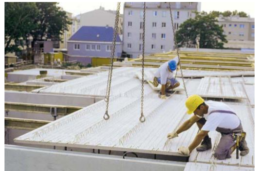
Obr. 8: Uloženie stropných dosiek
