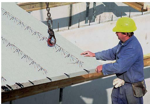
Obr. 13: Dvíhanie stropnej dosky
